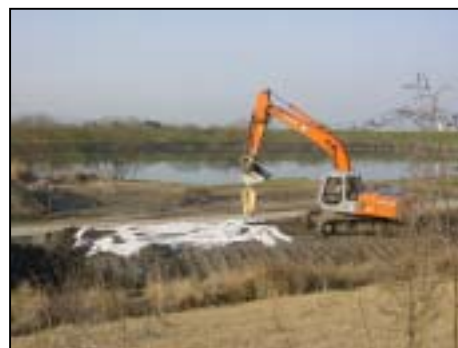
固化材散布作業
