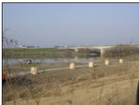
改良対象となる地山の整形（土量計測） 固化材配置作業
